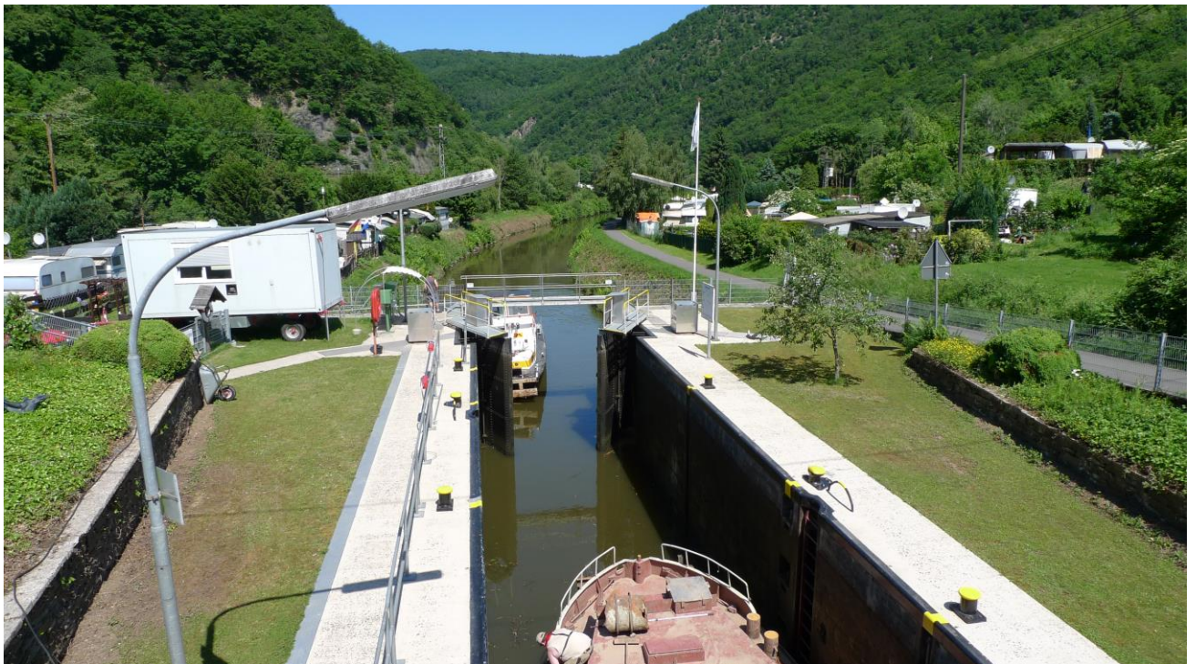
An der Schleuse Ahl.
